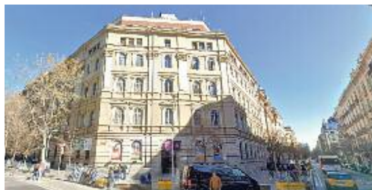
La façana del col·legi Jesuïtes de Casp. Foto: Arxiu
