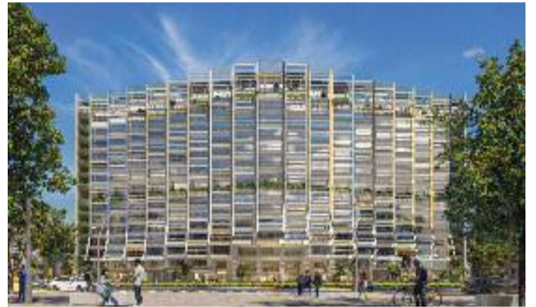
L'edifici Estel de l'avinguda Roma és l'antiga seu de Telefónica. Foto: ACN
