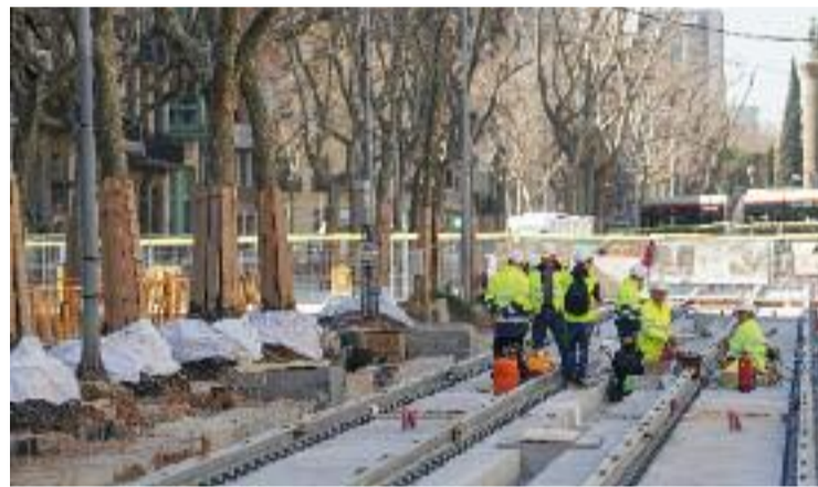
Les obres del tramvia a l'avinguda Diagonal. Foto: Ajuntament
