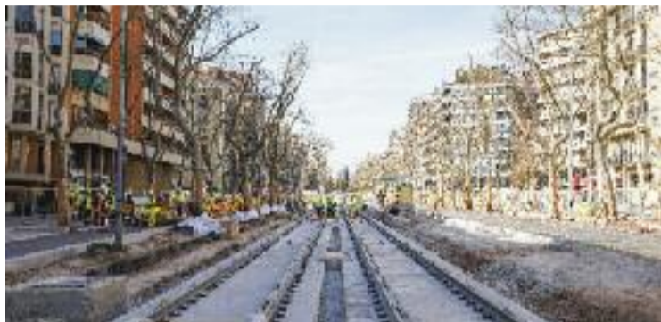
Una imatge de les obres del tramvia, aquest dilluns al matí. Foto: Ajuntament
