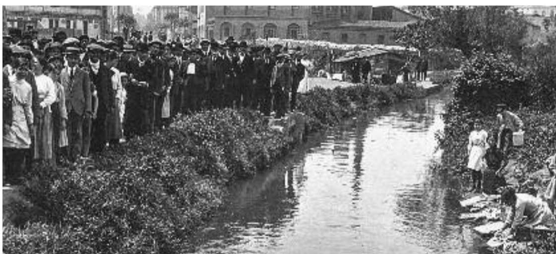
Inauguració de les obres de desviament del Rec Comtal el 1916. Foto: Arxiu Fotogràfic de Barcelona
