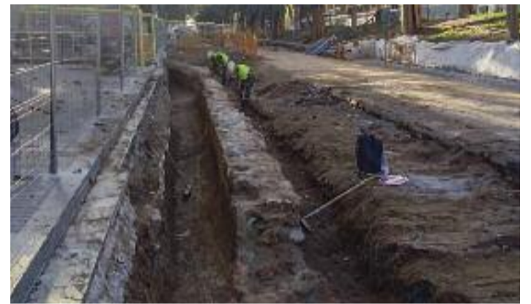
El tram del rec descobert a les obres del tramvia. Foto: Arxiu Històric Fort Pienc
