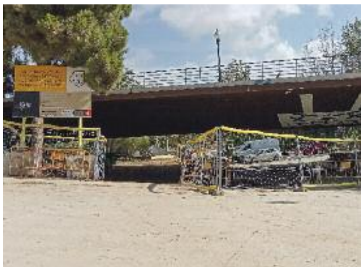
Les obres han patit tres mesos de retard. Foto: Línia Eixample
