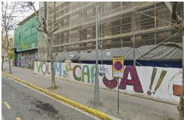
La nau industrial que s'haurà d'enderrocar. Foto: Arxiu
