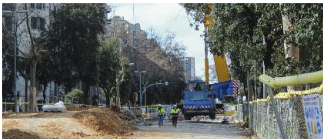
Dues tècniques en les obres del col·lector de l'avinguda Diagonal. Foto: Línia Eixample
