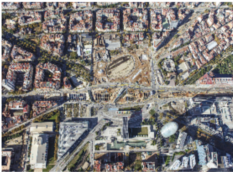
Imatge aèria de les obres de Glòries. Foto: Ajuntament
