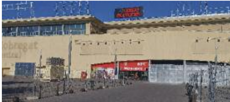
Entrada principal del centre, tancada amb planxes. Foto: Línia Cornellà
