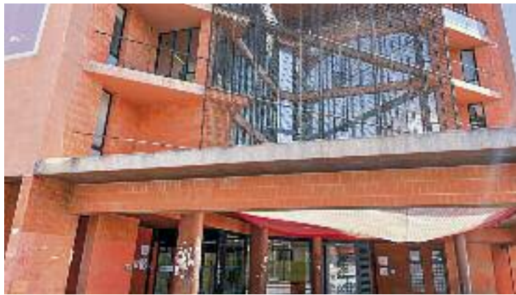
Aspecte actual de l'edifici, amb les xarxes de protecció. Foto: Ajuntament
